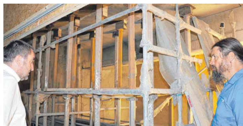
Norbert Schültke (links) und Alfons Schmid begutachten den Sanierungsfortschritt.
