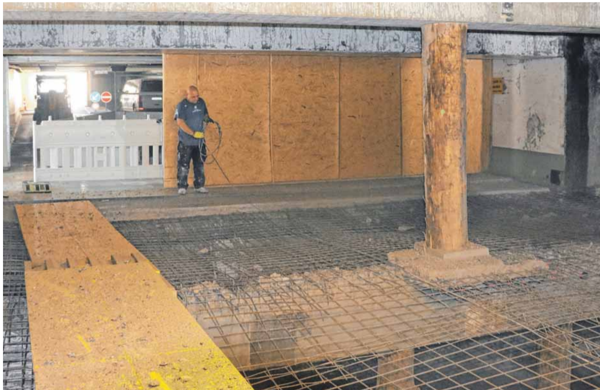
Wo künftig wieder Autos ins Parkhaus am See ein- und ausfahren werden, klafft im Boden derzeit ein großes Loch.
